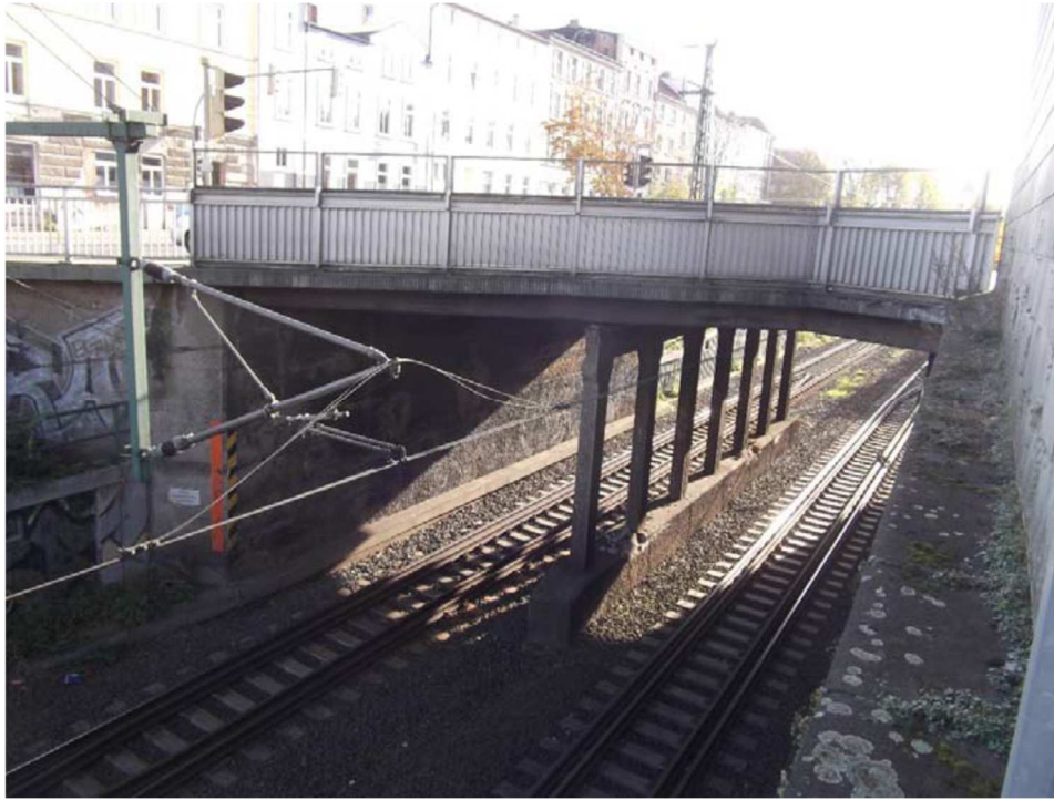
Bild 3: Brückenansicht von Norden
