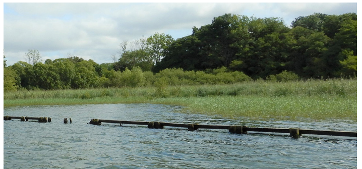
Der alte Röhrichtschutz vor der Hasenseebucht der Insel Ziegelwerder wird ersetzt durch eine 100 Meter lange Holzpalisadenreihe in Kombination mit Verbisschutzzäunen.
