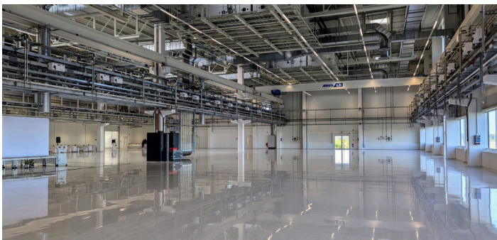
Auf einer Fläche von 3.300 m 2 ist die neue Produktionshalle der Ypsomed Produktion GmbH entstanden. © Landeshauptstadt Schwerin/Ulrike Auge
