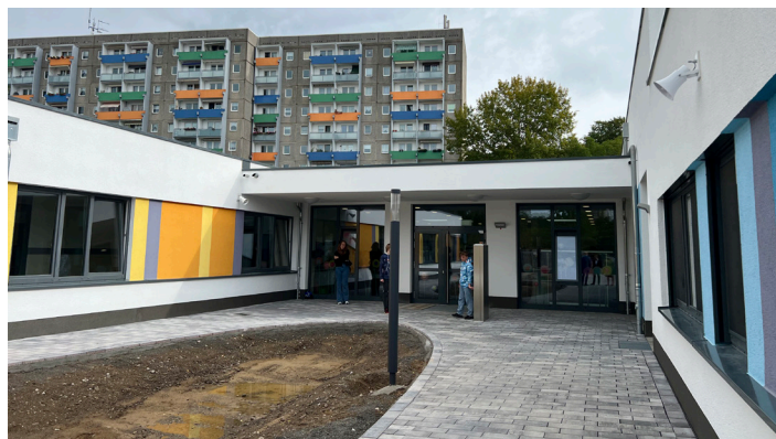
Der Eingangsbereich der neuen Förderschule „Albert Schweitzer“ © Landeshauptstadt Schwerin/Michaela Christen
