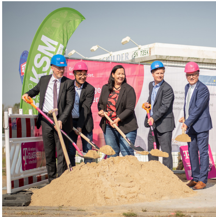
Spatenstich für den Breitbandausbau im Gewerbegebiet Am Fährweg.
