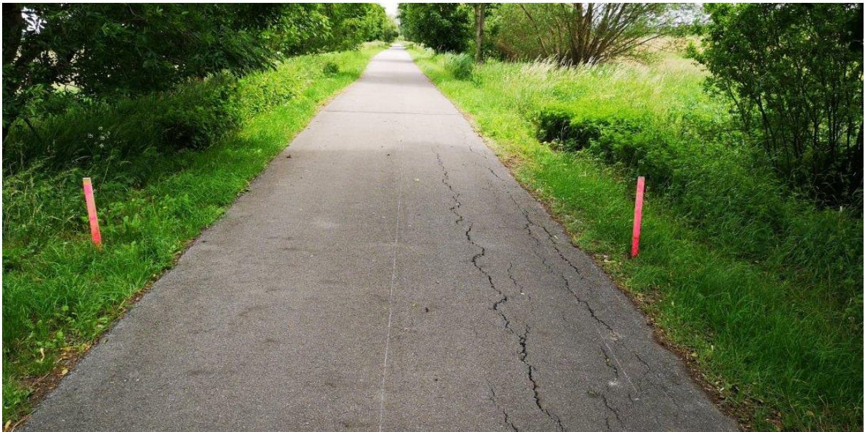
Foto 3: Profil 3, 947 m vom Bauabschnittanfang
