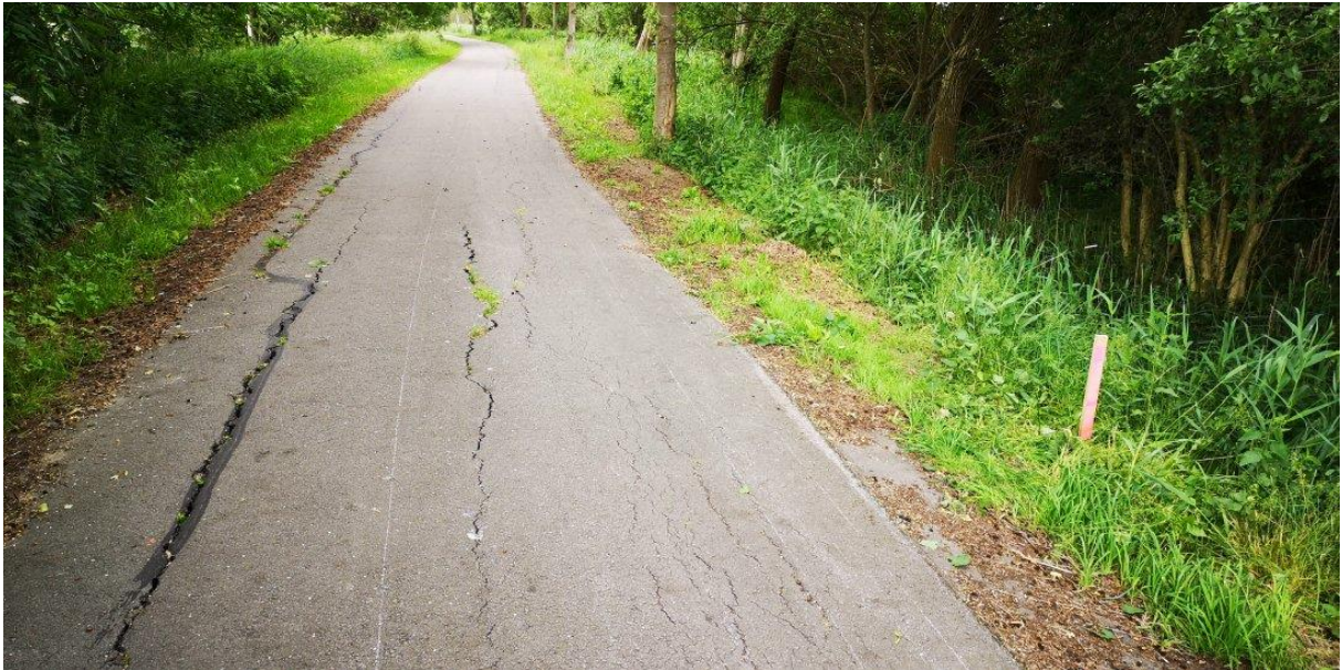
Foto 2: Profil 2, 552 m vom Bauabschnittanfang
