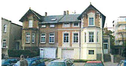
unterschiedliche Qualitätsstufen der Sanierung an einem Gebäude
