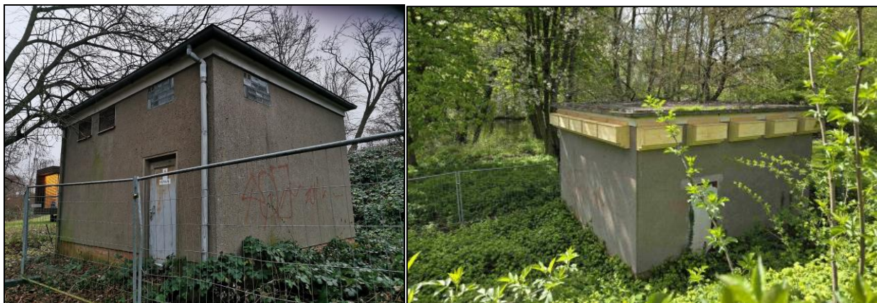
Abbildung 2: Trafohäuschen mit errichteten Übergangsquartieren.
