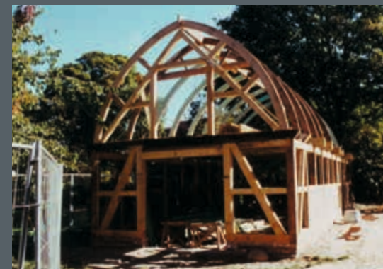
1997 erhält die 1825 im Garten errichtete Remise ein originalgetreues neues Dach.
