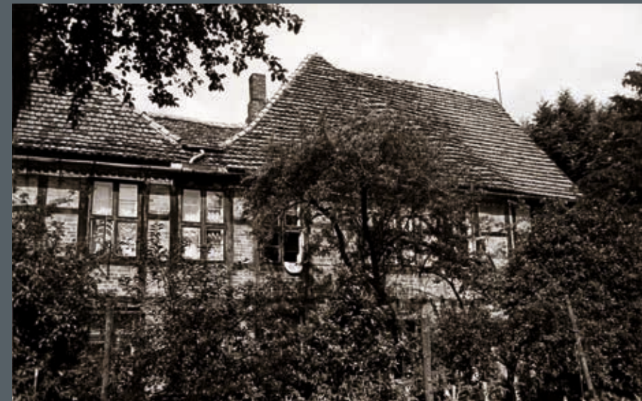
Das Haus im Sommer 1957 von der Straßen- und Gartenseite aus gesehen.
