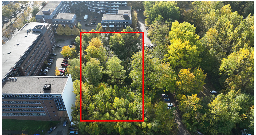
Auf dem Baugrundstück im Erbbaurecht sollen Wohnheimplätze für Studierende und Auszubildende entstehen. © ZGM
