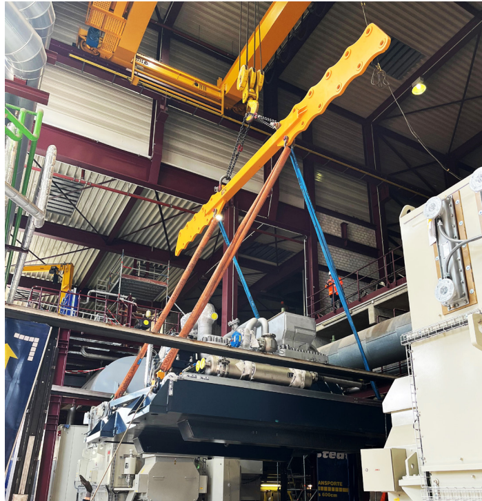
Millimeterarbeit: mit dem Tieflader wurde die neue Dampfturbine bis in die Kraftwerkshalle hineingefahren und anschließend zwischen den beiden Gasturbinen mit dem Hallenkran entladen.
